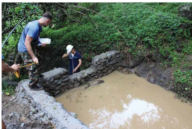
Les agents de la DIREN vérifient également la mise en œuvre des mesures préconisées, notamment l'installation de bassins de décantation
