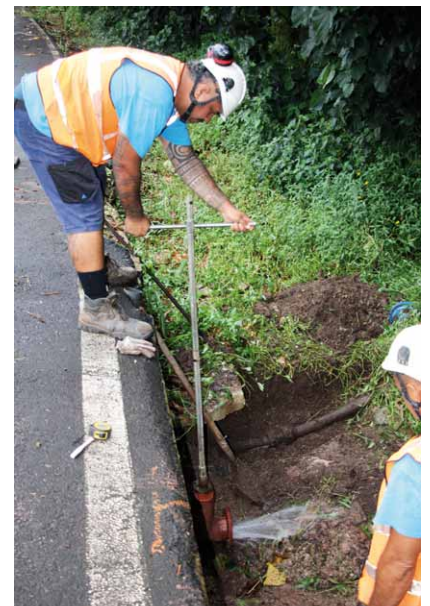
Les agents de la Polynésienne des Eaux préparent la pose des débitmètres
